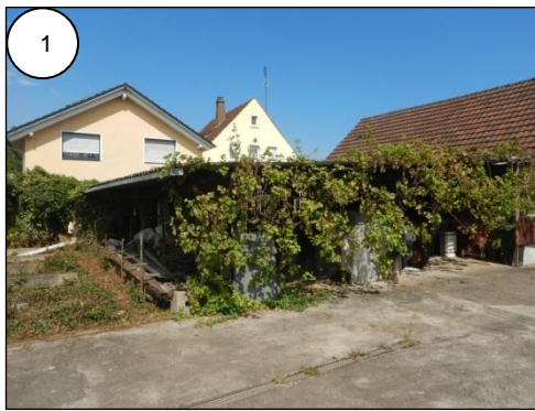
Carport-Anbau neben dem Garagengebäude mit abgestelltem Traktor, weiteren Maschinen und Materialien. Mit wildem Wein überwachsen. Blickrichtung Nordost
