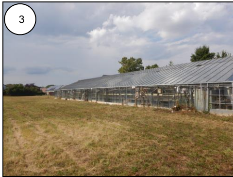
Gewächshaus des ehemaligen Gärtnereibe- triebs. Blickrichtung Nordwest
