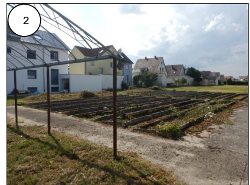
Betonstrukturen der ehemaligen Beet Flächen. Die Strauchvegetation wurde deutlich zurück- geschnitten. Blickrichtung Südwest
