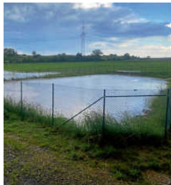
Retentionsbecken unterhalb von „Aichert Nord“
