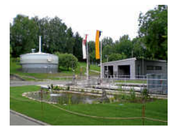
Kläranlage Fotos: Albrecht Hamm
