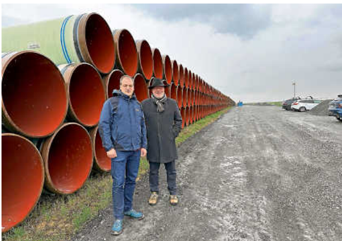
Die Bürgermeister von Bönningheim und Erligheim bestaunen den beachtlichen Rohrlagerplatz Fotos: Stadtverwaltung
