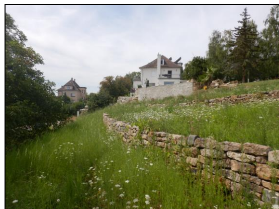
Umgesetzte Trockenmauern auf Flurstück 3730, nördlich des Geltungsbereichs
