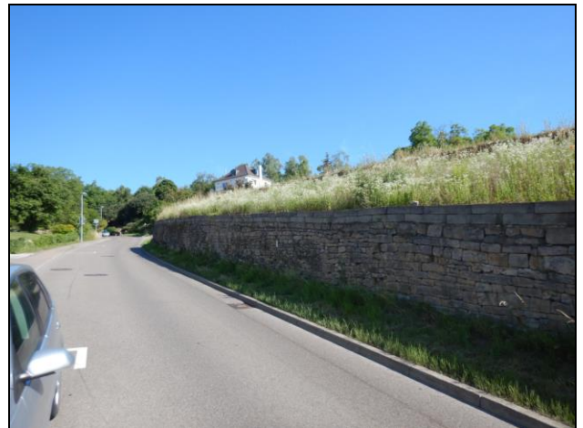
Bestehender Mauerstandort an Brackenheimer Straße mit Böschung hangaufwärts.
