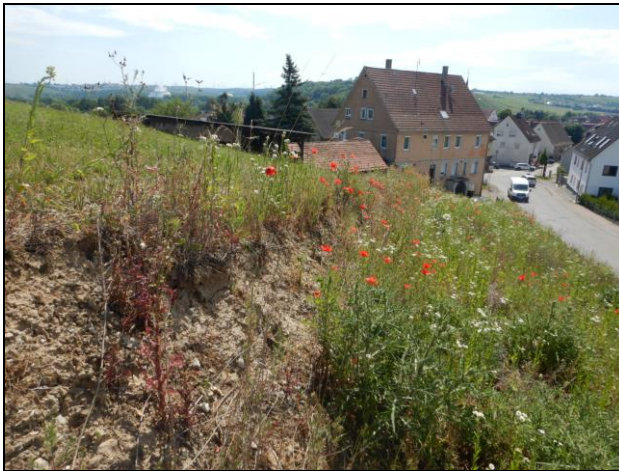
Ehemaliger Standort Trockenmauer mit vegetationsfreier Böschung und lückiger Saumvegetation.
